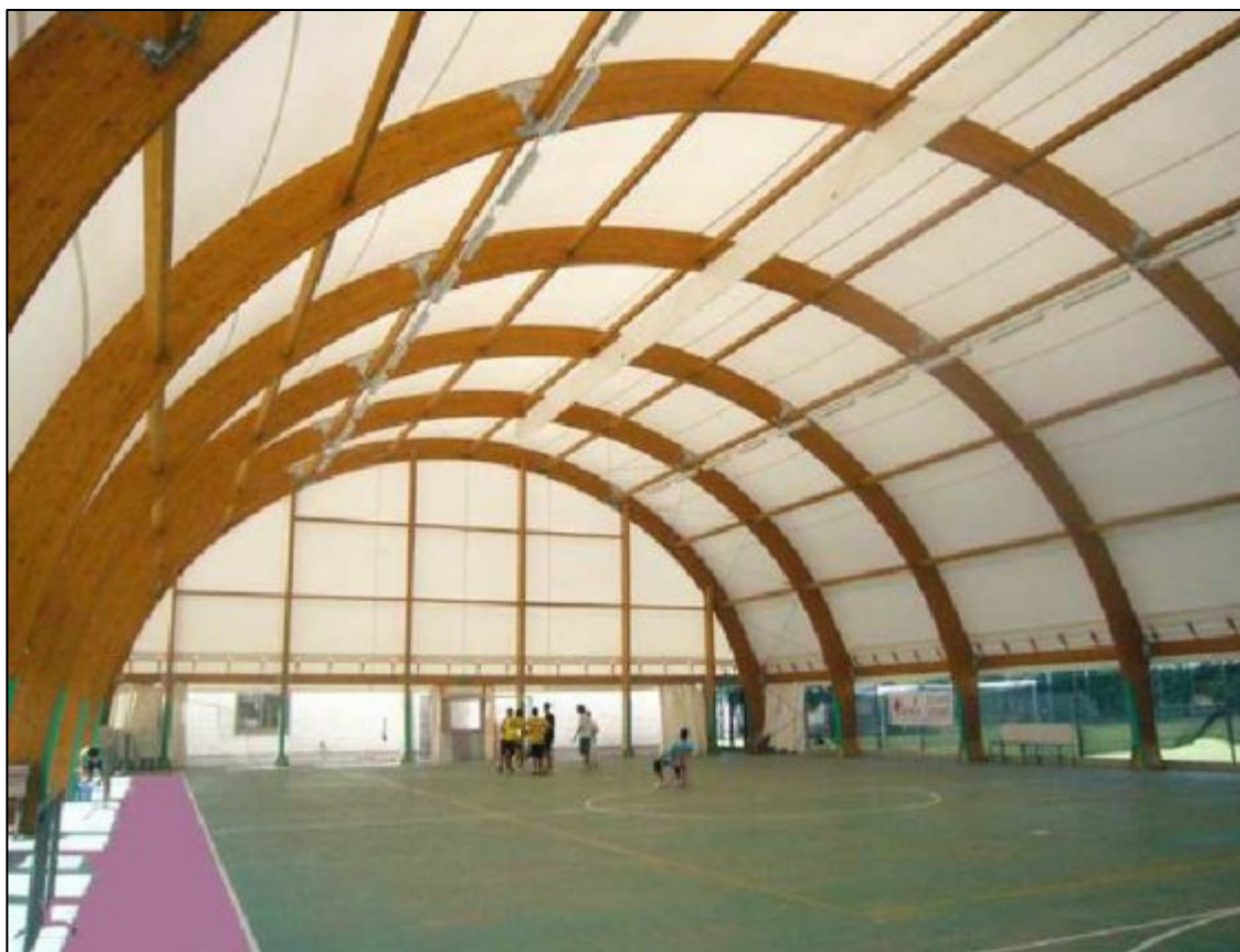
Fig. 3.1.1- Copertura della pista.
